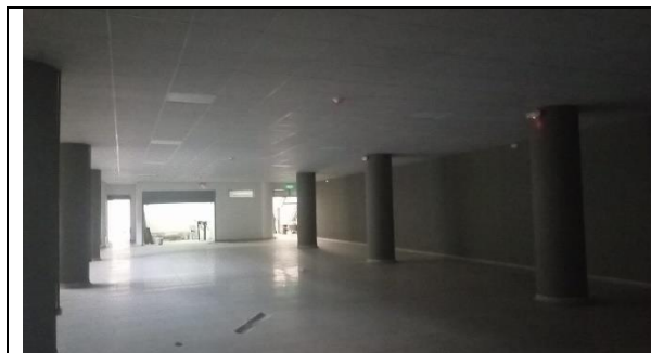
Instalación de sistema contra incendio
