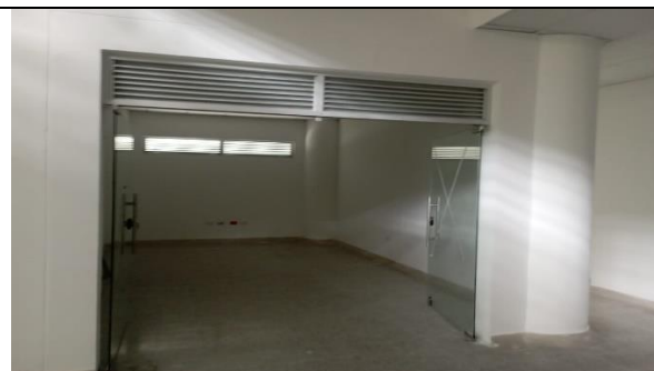
Instalación de puertas en vidrio
