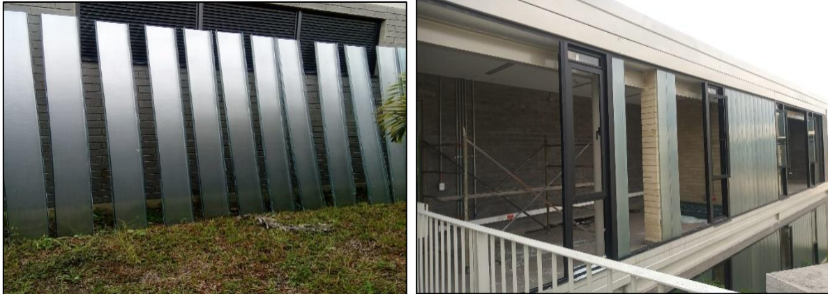
Imagen 48 - Retiro, suministro e instalación de ventanales oficinas del patio taller
