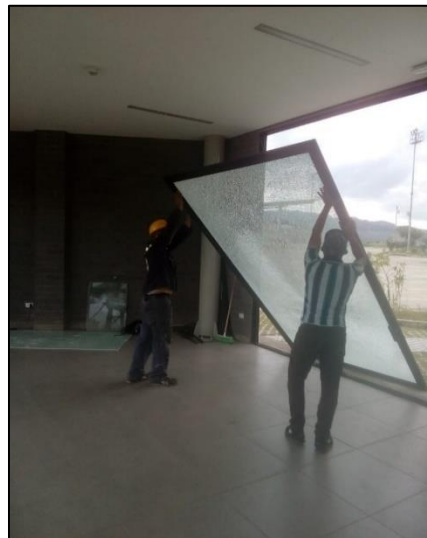
Imagen 49 - Retiro, suministro e instalación de ventanales oficinas del patio taller
