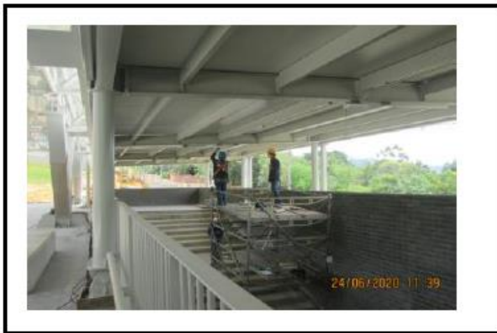
INSTALACIÓN CUBIERTA RAMPAS
