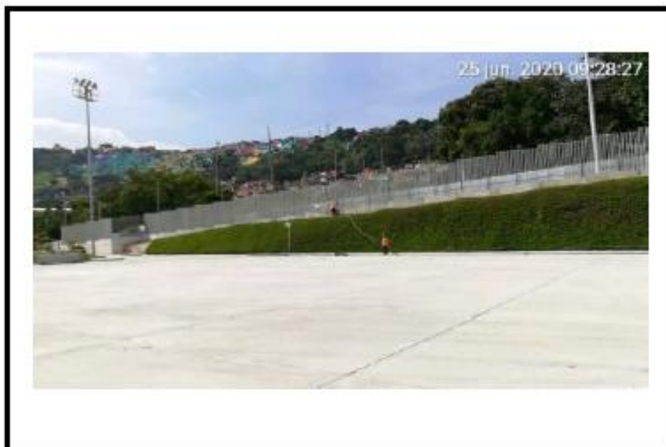
PAVIMENTO PATIO TALLER www.bucaramanga.gov.co
