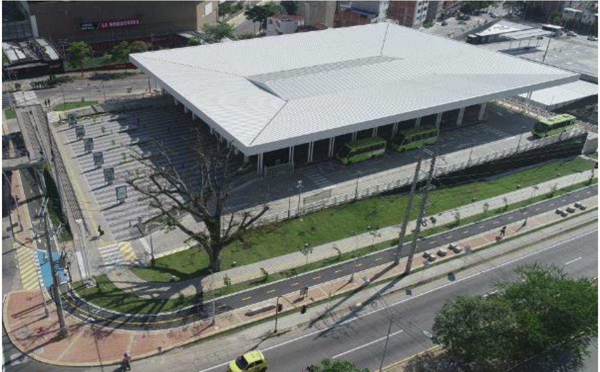
Estación de Transferencia en Operación.
