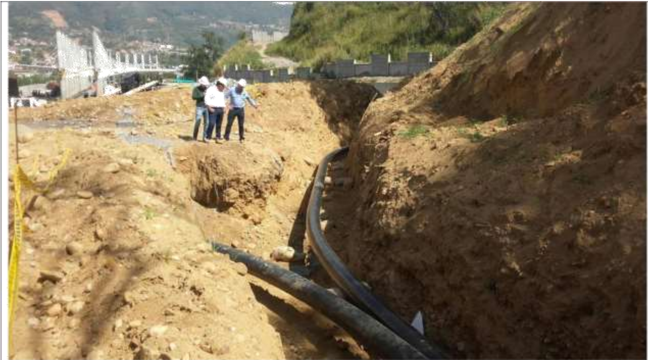
Traslado línea Gasoducto Gibraltar - Bucaramanga
