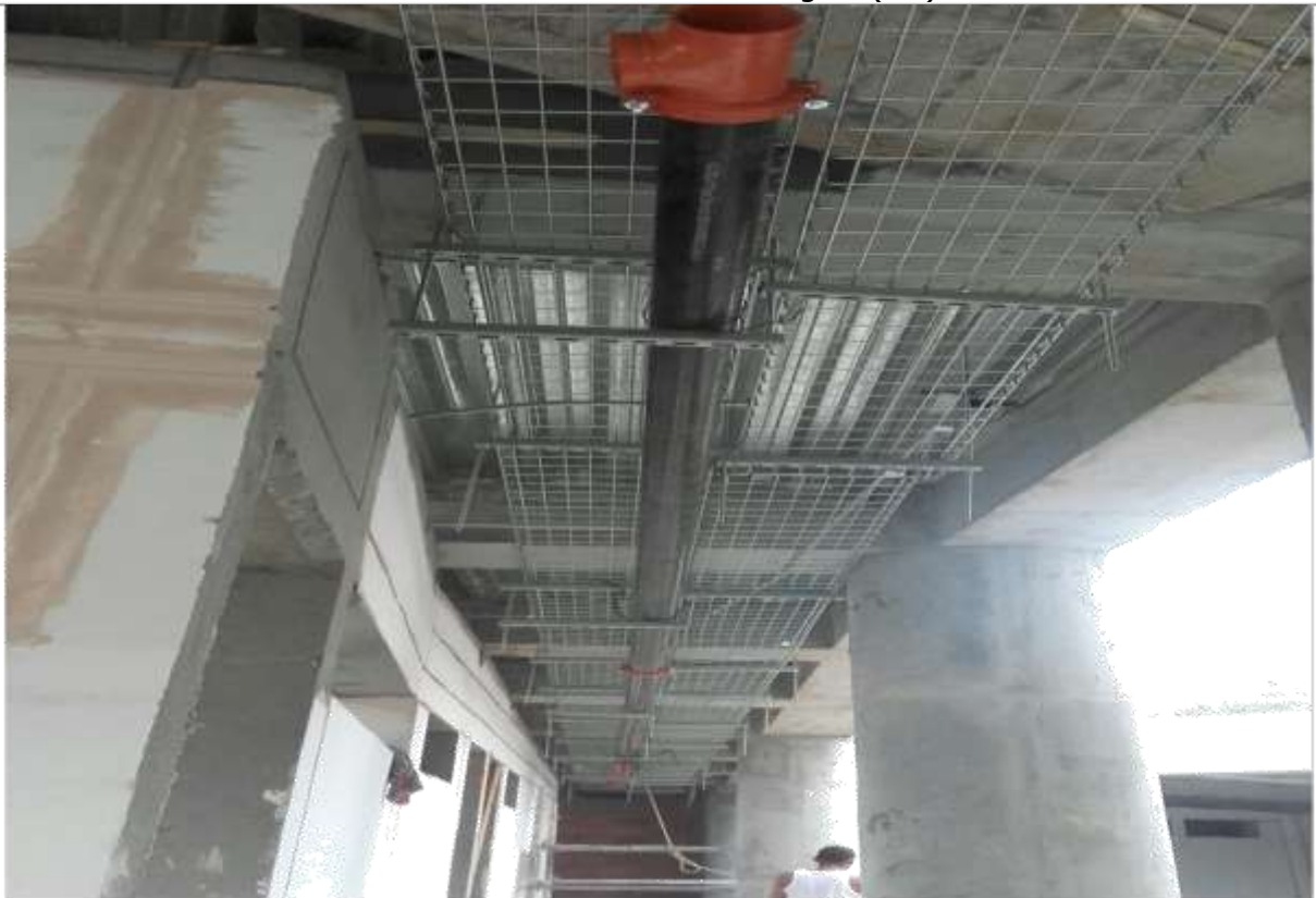
Instalación de Bandejas Portacables y Tubería Contraincendio
