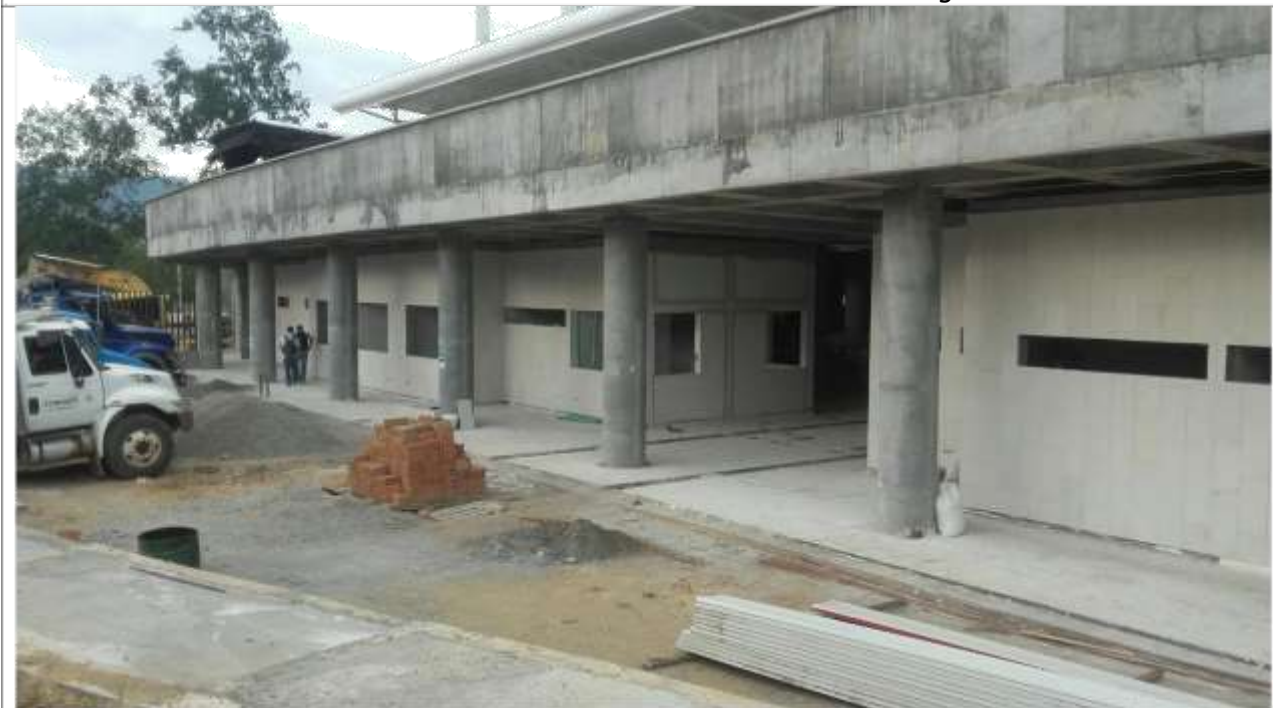
Instalación de Enchapes y Acabados
