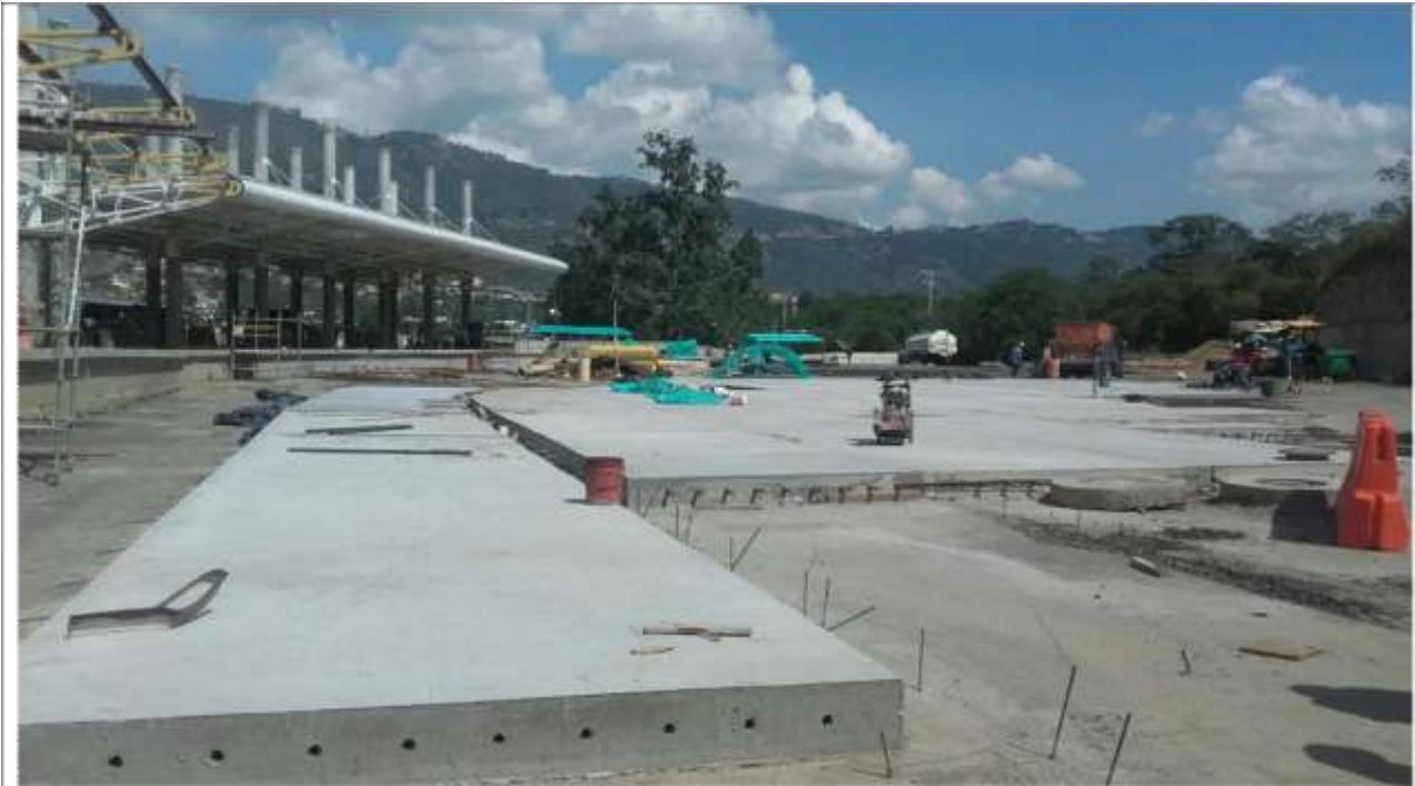
Construcción de Pavimento Rígido (MR)
